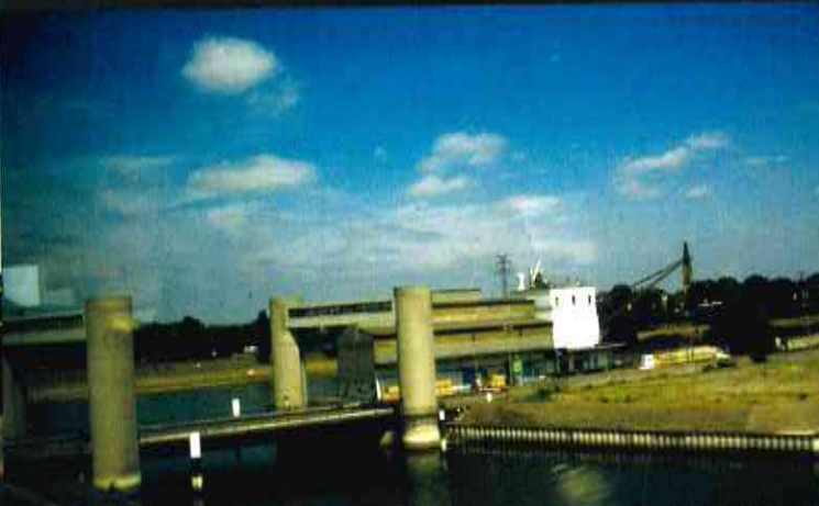
... an der Hubbrücke vorbei
