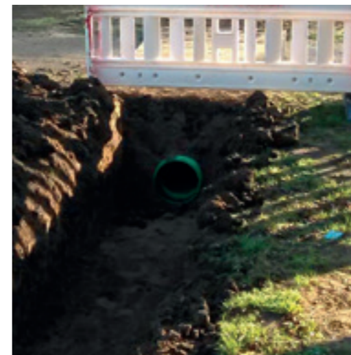
links oben Herstellung des Grabens zur Verlegung der Rohre · rechts & unten Seppl-Herberger- Stadion, Übergabestation Fernwärme
