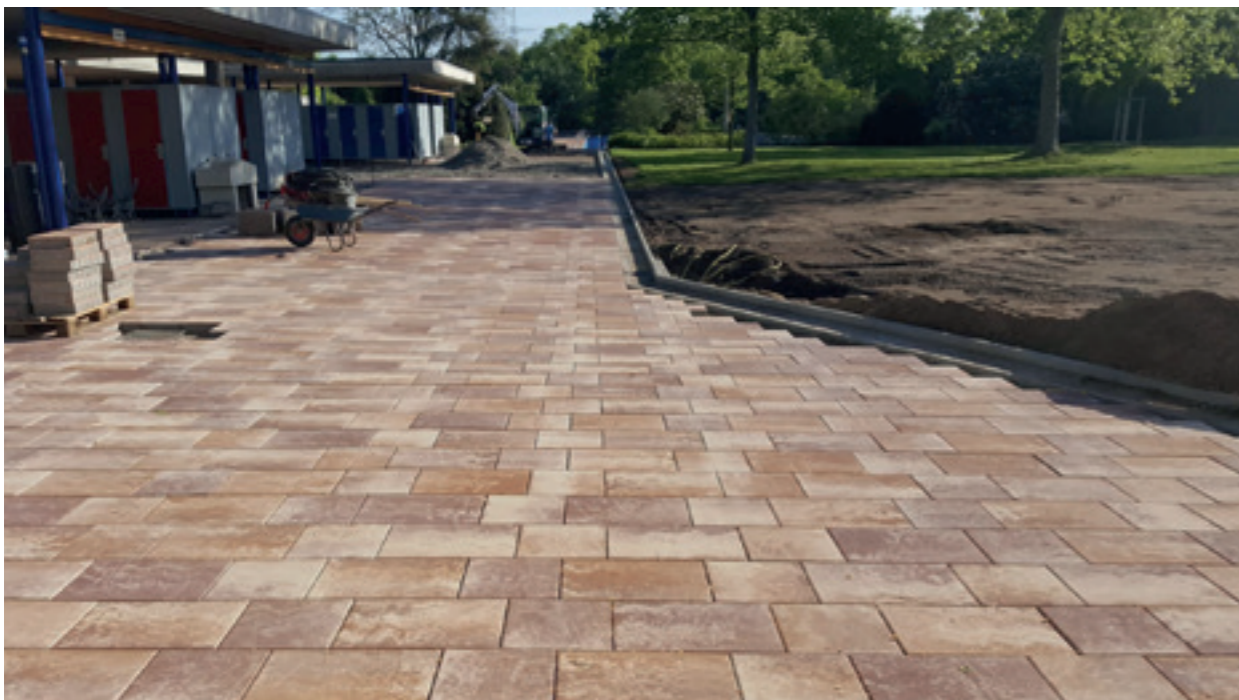
Parkschwimmbad Rheinau, Vorplatz
