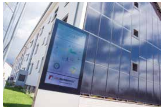
Sie schonen das Klima und sparen Energie: Beim SQUARE-Projekt wurden aus zwei Bestandshäusern ökologische Modellhäuser, Photovoltaik-Module an der Fassade inklusive.
