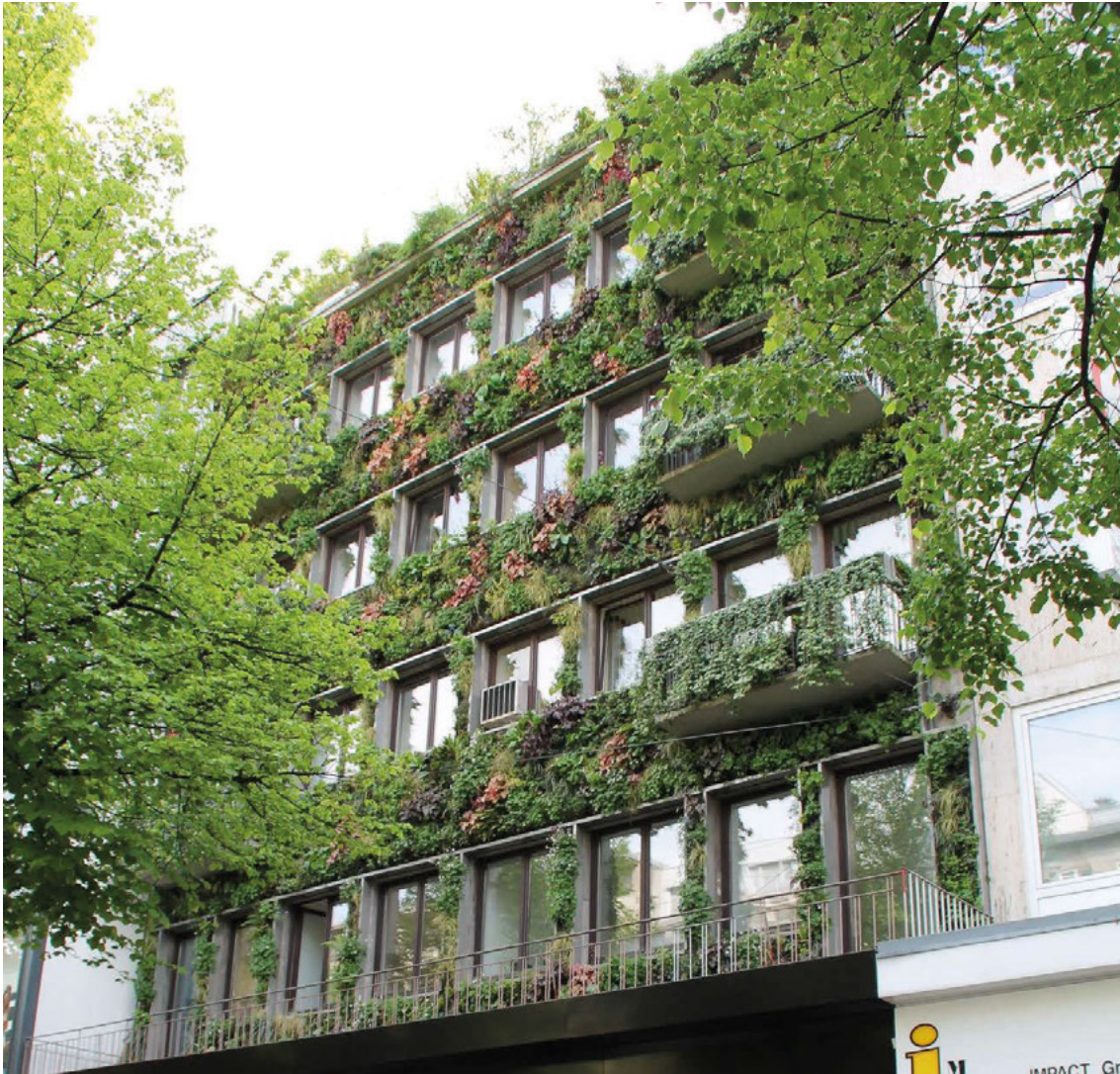
Abbildung 36: Fassadenbegrünung an O7,6 (Stadt Mannheim Dez. V)
