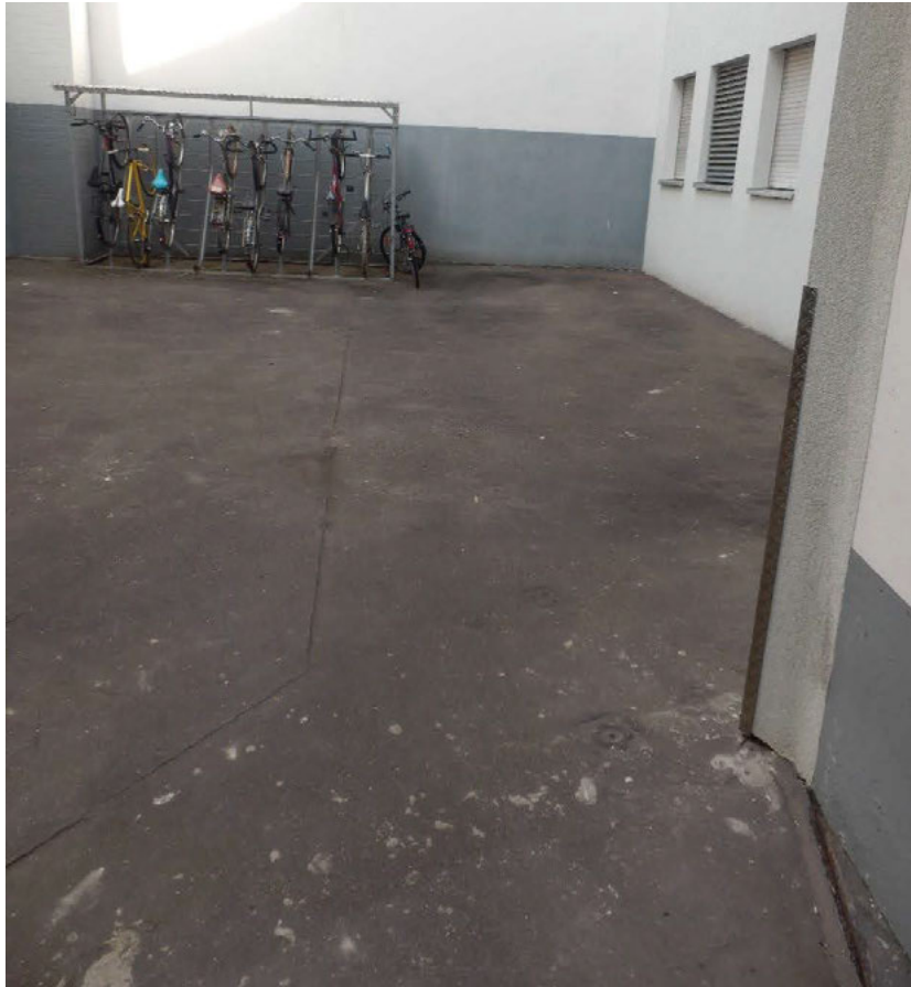
Abbildung 54: Innenhof in U5, der als Verkehrs- und Stellfläche verwendet wird
