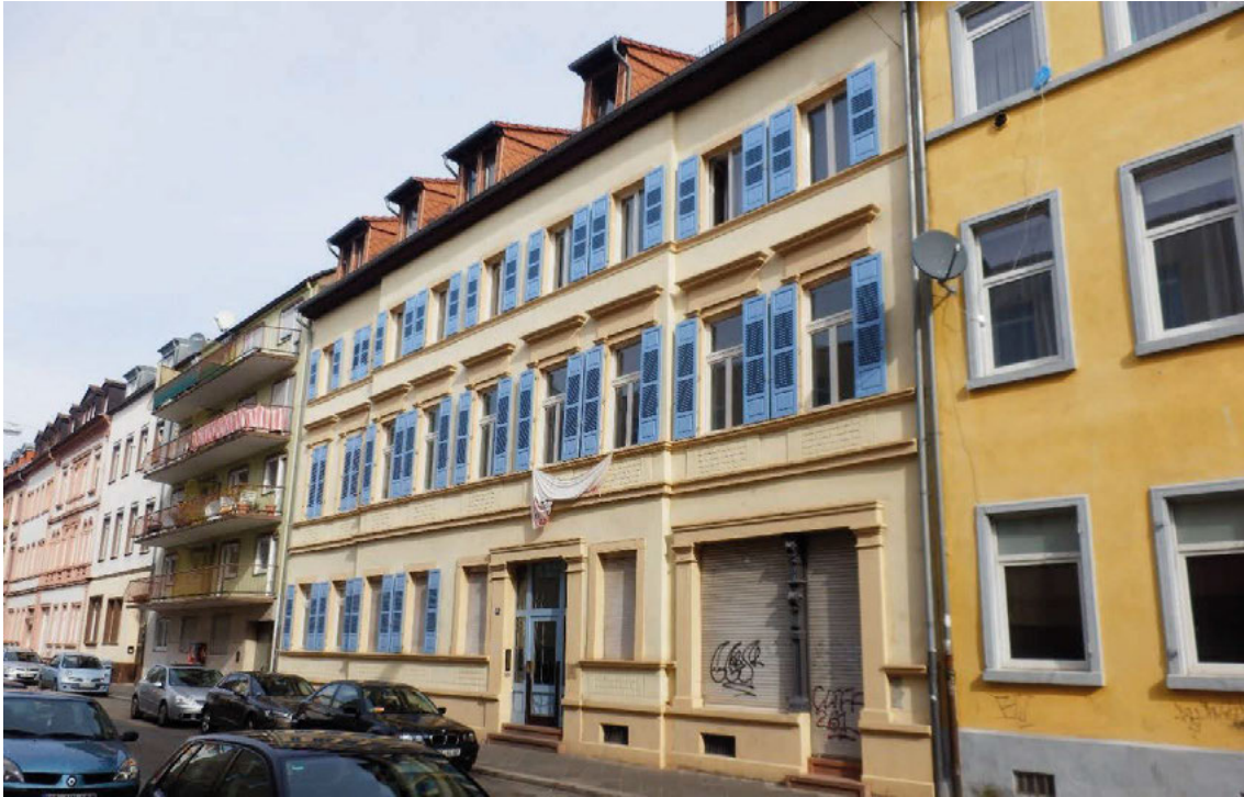
Abbildung 26: G7 von F7 aus (Blick nach Norden)
