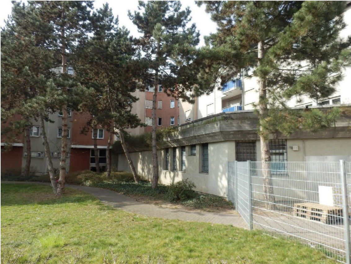
Abbildung 53: Hinterhof der GBG Gebäude in H5 (südlich des ZI)
