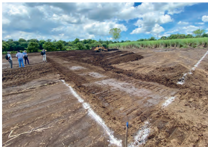
Vorbereitende Arbeiten für den Bau des Sickerbeckens in El Viejo
