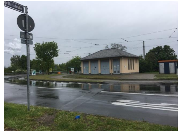
Blick auf Umspannstation und Toilettenhäuschen/Fahrerpausenraum rnv
