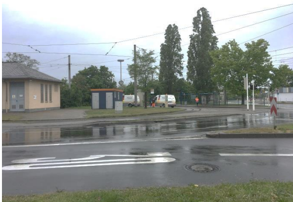
Blick von Südosten/Haltestelle Straßenbahn mit Fahrgastunterständen, markante Baumgruppe Pappeln/Linden/Ahorn
