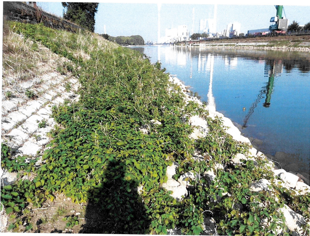
Abbildung 7-5. Blick auf den Böschungsfuß mit Wasserbausteinen (Aufnahme am 18.09.2021).
