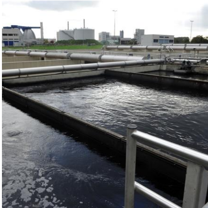
1 Pulveraktivkohleanlage
