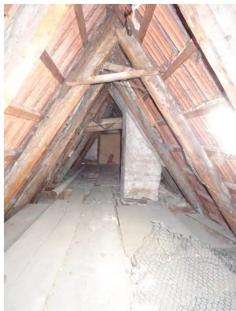
Abb. 24: Dachstuhl Rheingoldstraße 31 a
