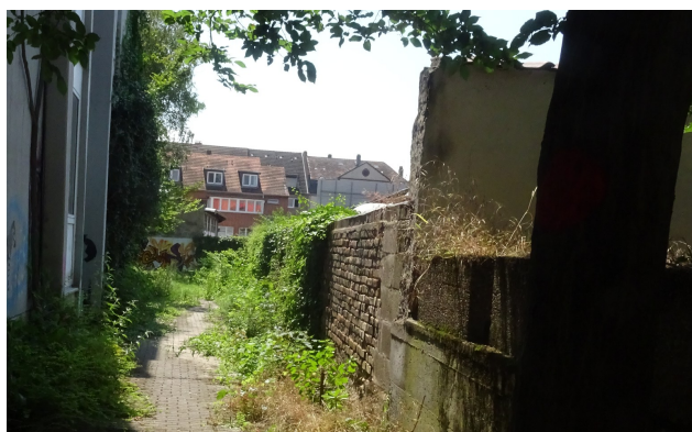
Abb. 5: Westseite Rheingoldstraße 31 Rheingoldstraße 31
