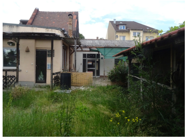
Abb. 14: Abbauten und Garten Rheingoldstraße 37
