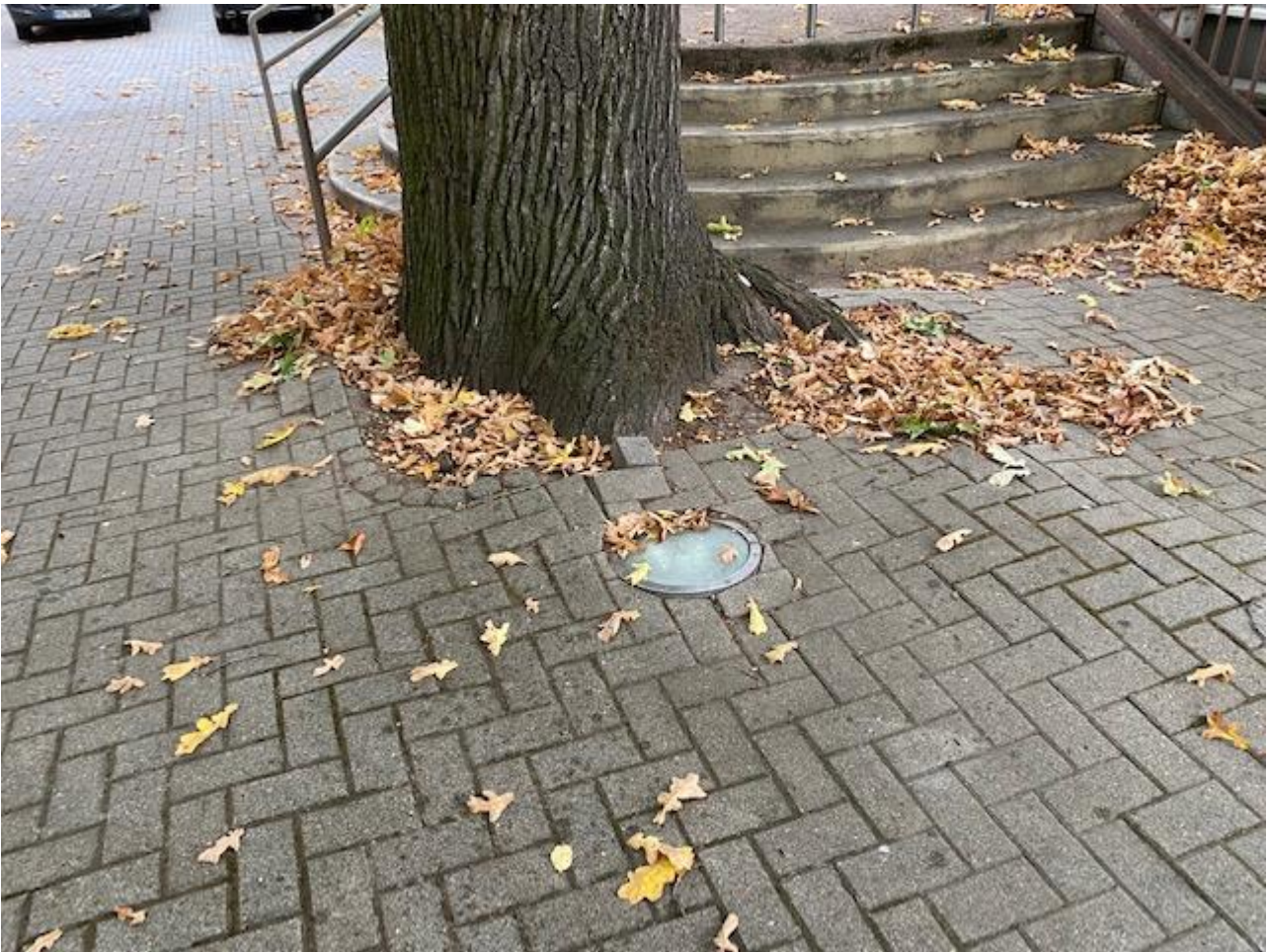
Abbildung 1 Stammfuß der Eiche mit Pflasterhebungen
