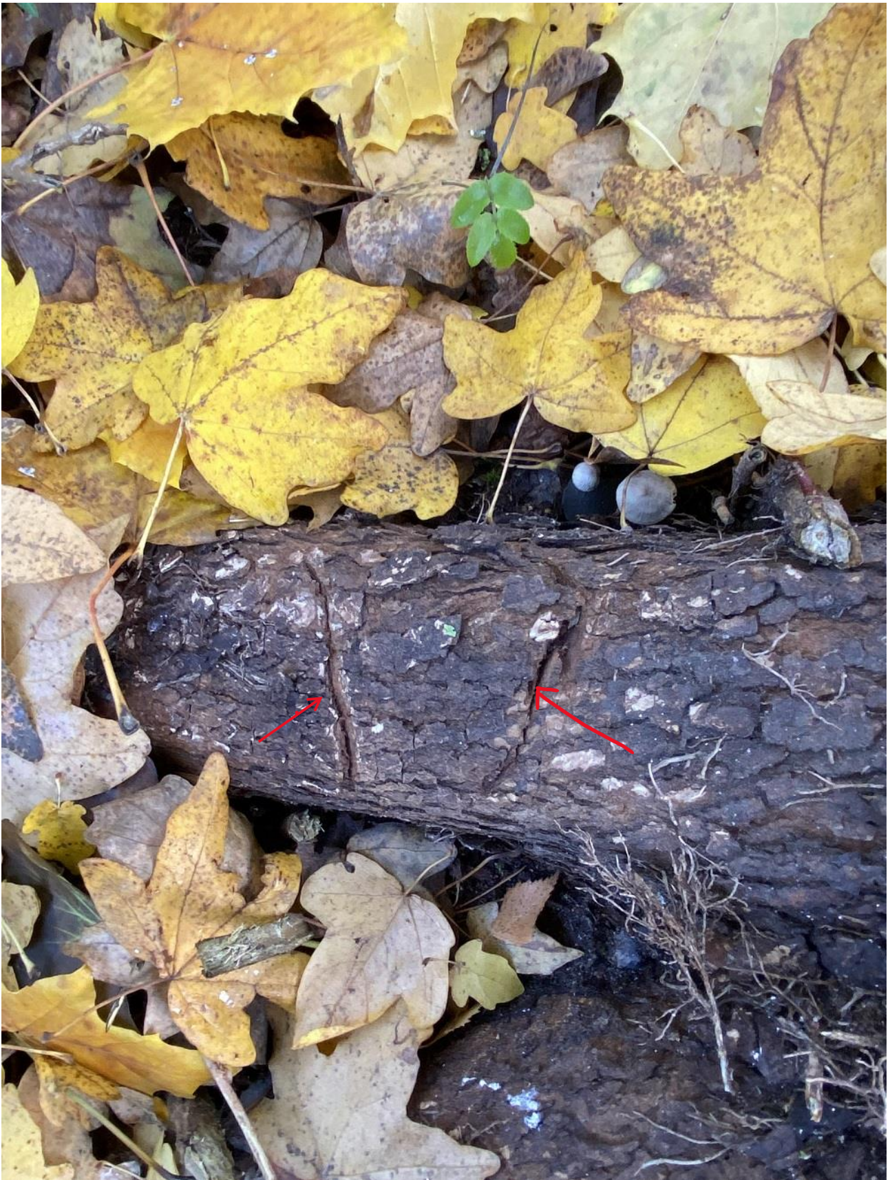
Abbildung 14, Bei der Efeubeseitigung wurden die Wurzeln des Baumes angesägt!
