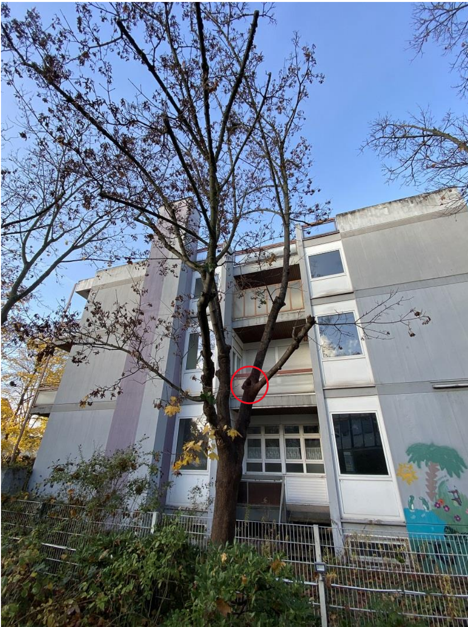
Abbildung 25, der gleiche Ahorn nach Beseitigung des Efeus der rote Kreis zeigt die Faulstelle
