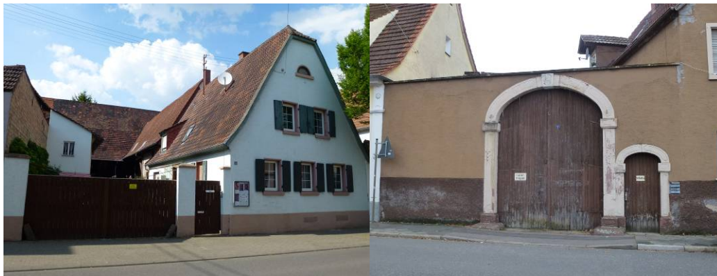
Abbildung 20: Altes Gehöft mit ehemals landwirtschaftlicher Nutzung (li.), denkmalgeschütztes Hofportal (Quelle: Fotodokumentation)
