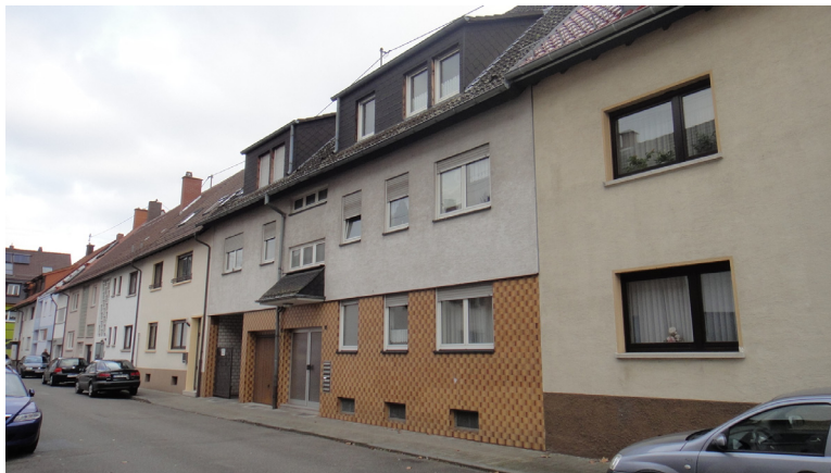
Abbildung 26: Typische Gebäude mit energetischem Erneuerungsbedarf (Quelle: Fotodokumentation)
