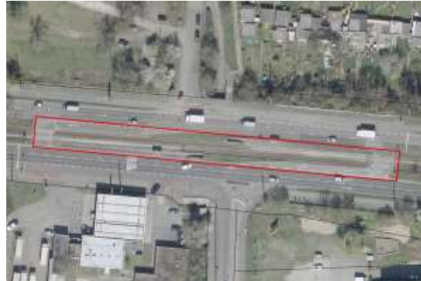
Bereich der barrierefrei umzugestaltenden Straßenbahnhaltestelle
