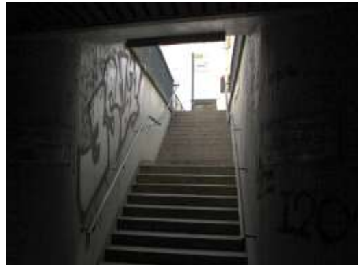
Aufgang zur Straßenbahnhaltestelle Sportpark (Neckarplatt)
