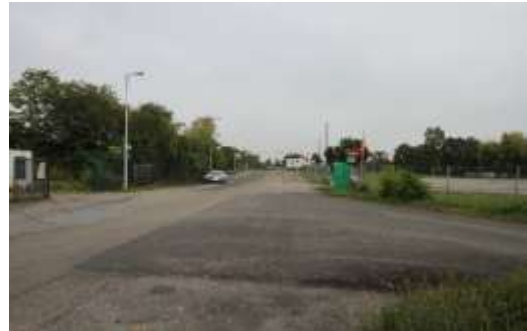
Ansicht des Straßenraums „Neckarplatt“ in Richtung Feudenheimer Straße
