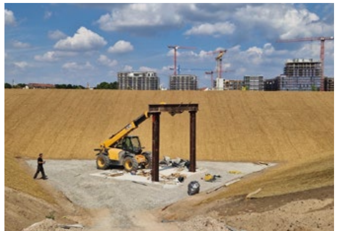
Bauansicht: Trägerkonstruktion von „Conversio“, Philipp Morlock / BUGA 23 Gelände Mannheim
