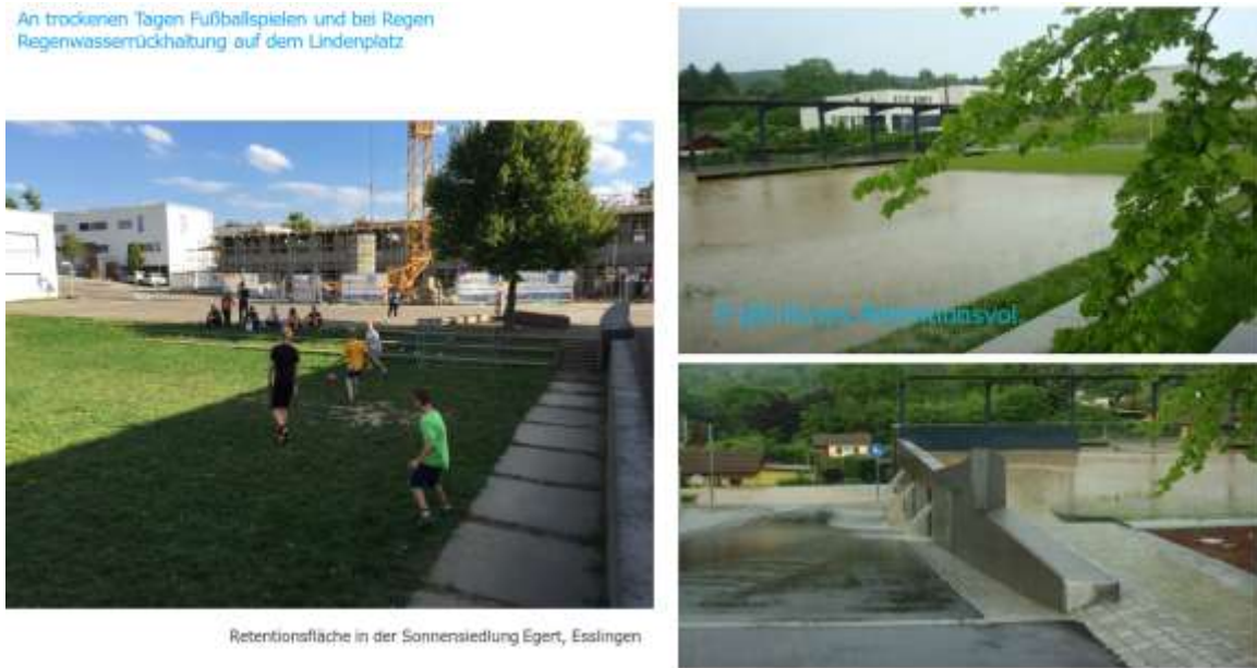
Abbildung 39 Multifunktionale nutzbare Retentions- und Versickerungsflächen erfordern eine angepasste Pflege und Wartung
